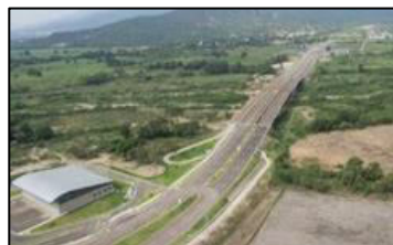
Puente Internacional Atanasio Girardot (Tienditas)
